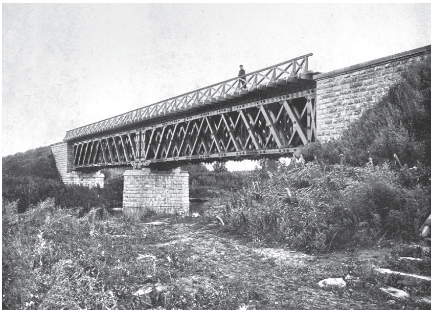
Деревянный железнодорожный мост через реку Лебязью
