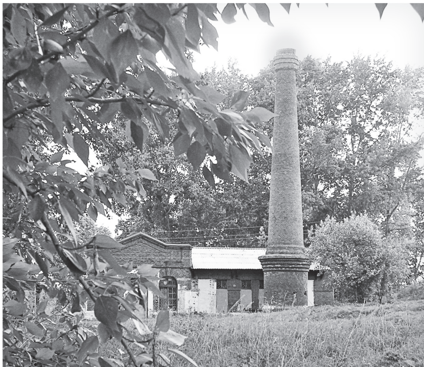
Водонасосная станция (водокачка)
