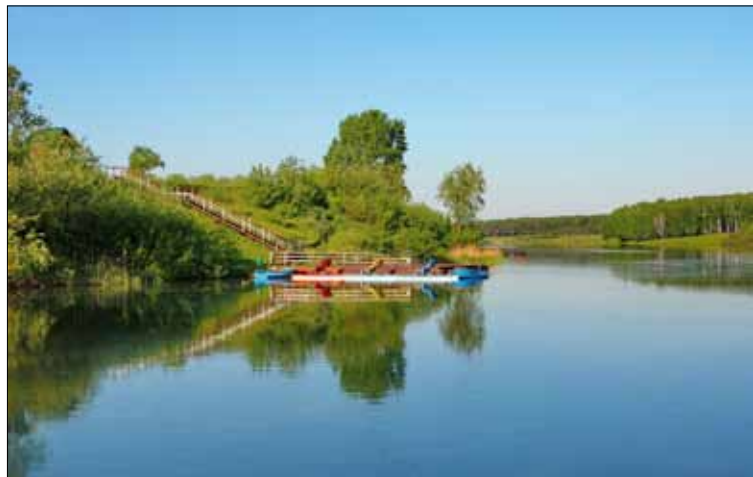
Водокачка, место забора воды в насосную станцию
