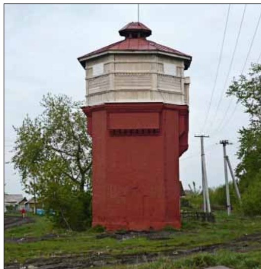
Отреставрированная водонапорная башня
