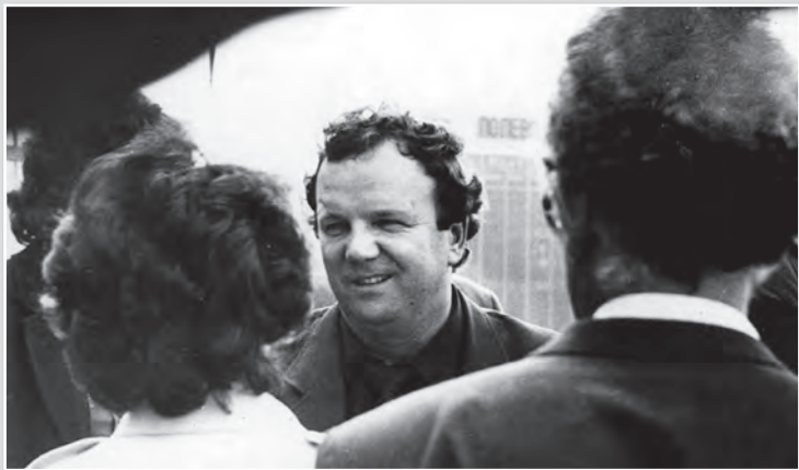
Планёрка на строительстве маслосырзавода (1989 г.)
